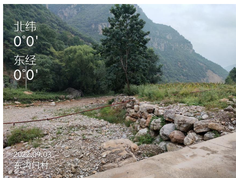
图 2.3-1 黄华峪河现状堤防
