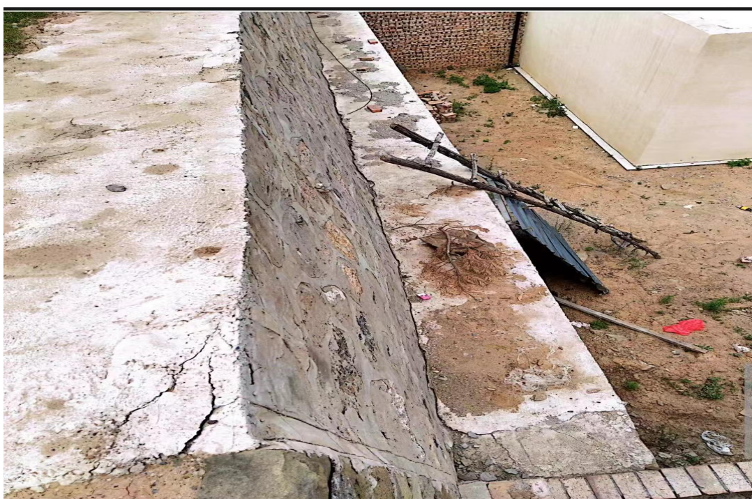
乡台县-金刚岭-墙身1 墙身2 之间裂缝
