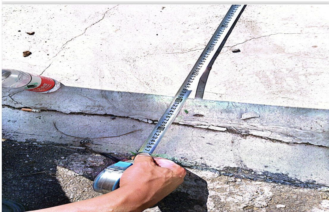
幸桃线-挡土墙水泥勾缝砂浆脱落
