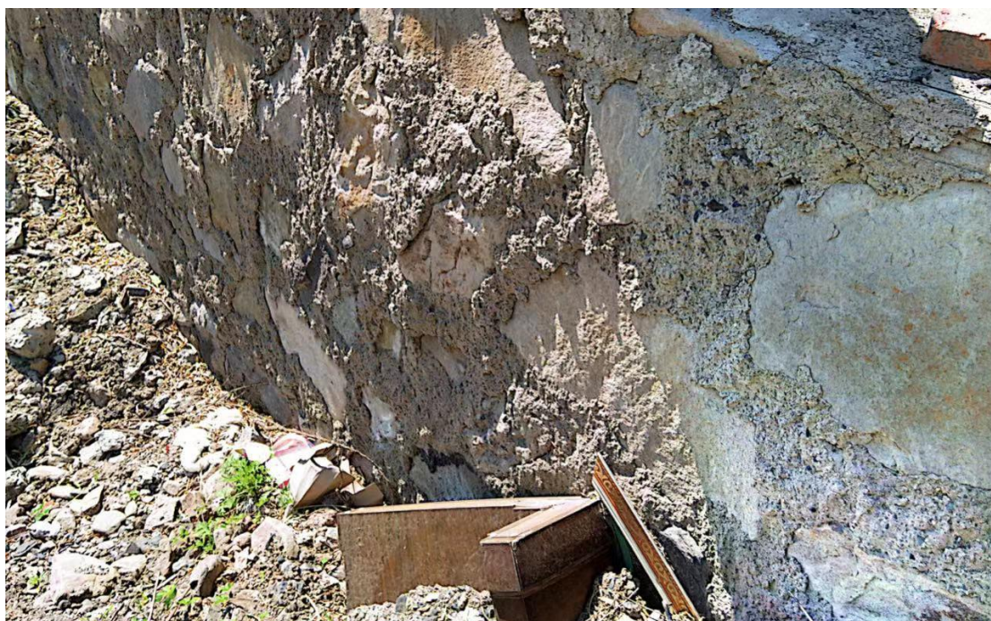
幸桃线-挡土墙水泥勾缝砂浆脱落
